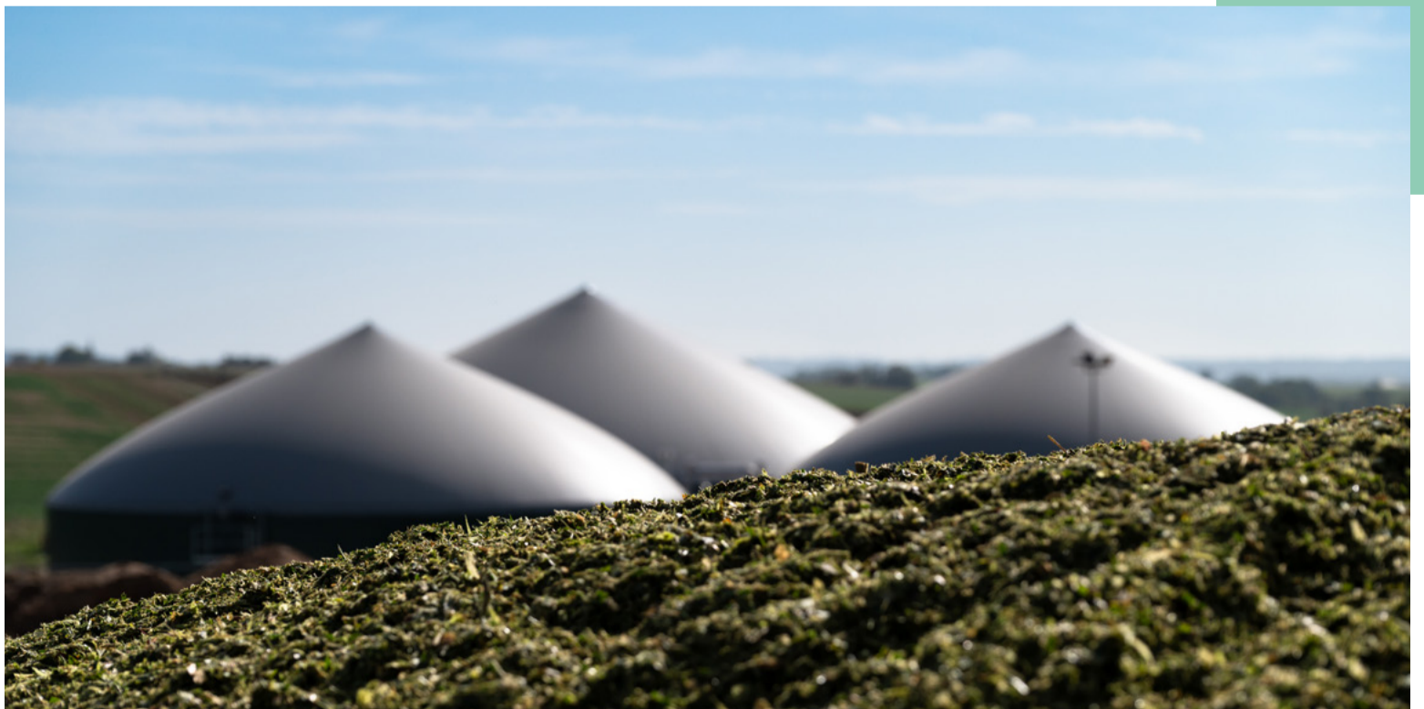
Le site du méthaniseur agricole Brie BioÉnergie, situé sur la commune de Chauconin-Neufmontiers, en Seine-et-Marne.
