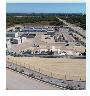
Démonstrateur industriel de *Power to gas* pour transformer le surplus d'électricité renouvelable en hydrogène et en méthane de synthèse pour l'injecter dans le réseau de transport et le stocker.
