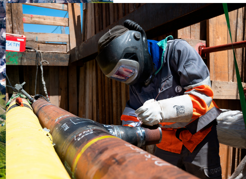
Chantier de la 1 re installation de rebours d'Ile-de-France à Mareuil-lès-Meaux, en Seine-et-Marne
