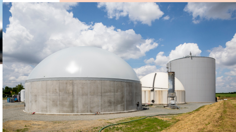
Méthaneur et digesteur du site de Bioloie (Loire-Atlantique)
